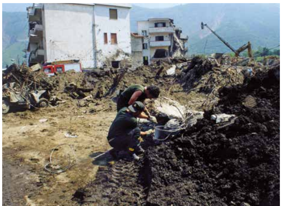
Foto 41. La frana di Sarno del maggio 1998.
