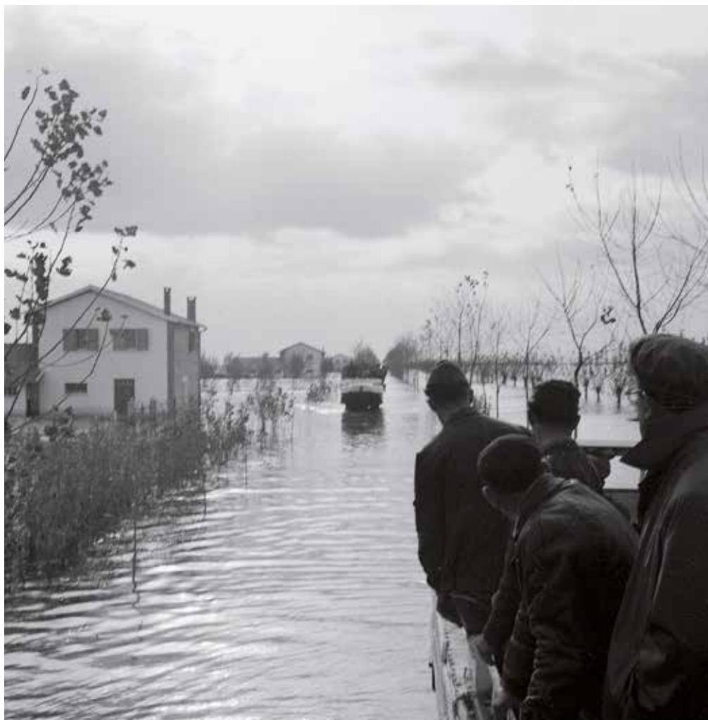
Foto 23. L'alluvione del Polesine in Veneto nel novembre del 1951.
