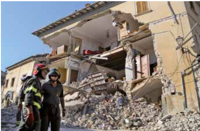
Foto 4. Amatrice, Rieti, 2016. I crolli causati dal terremoto del 24 agosto.
