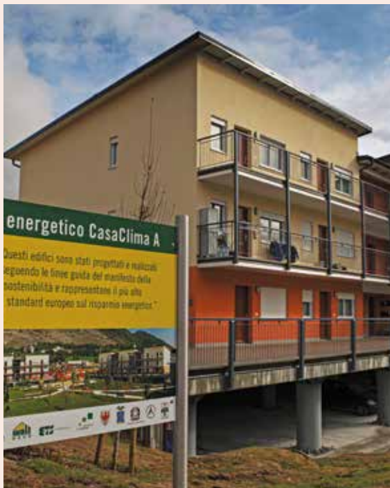
Foto 92. L'Aquila, 2009. Edificio realizzato nell'ambito del Progetto CASE-Complessi Antisismici Sostenibili Ecocompatibili.
