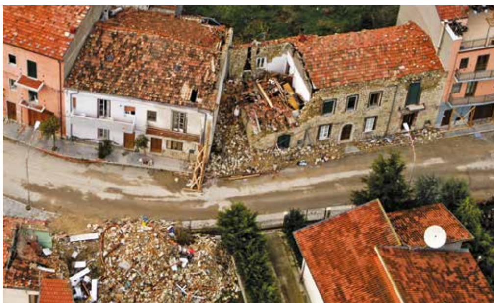
Foto 107. San Giuliano di Puglia, Campobasso, 2002. Crolli causati dal terremoto del 31 ottobre.
