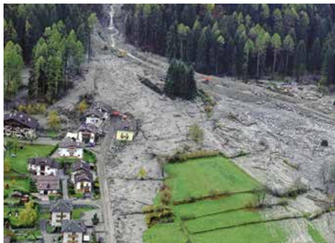
Foto 112. Trento, 2018. Danni alle abitazioni causati da un'eccezionale ondata di maltempo.
